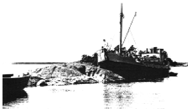
Strömmen kom till ön den 30 juni 1964 med Älvkarleby Kraft- verks kabel.
